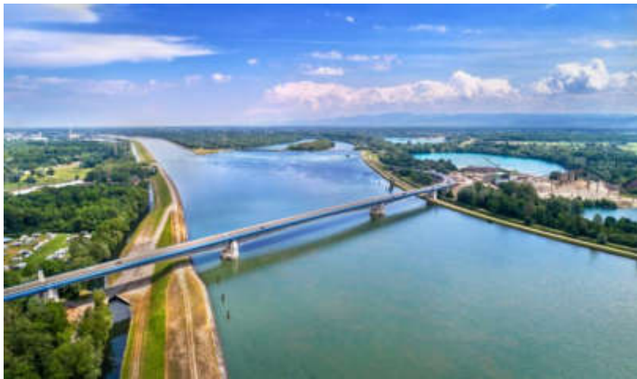
Pierre-Pfimplin-Brücke zwischen Frankreich und Deutschland - © Leonid Andronov
